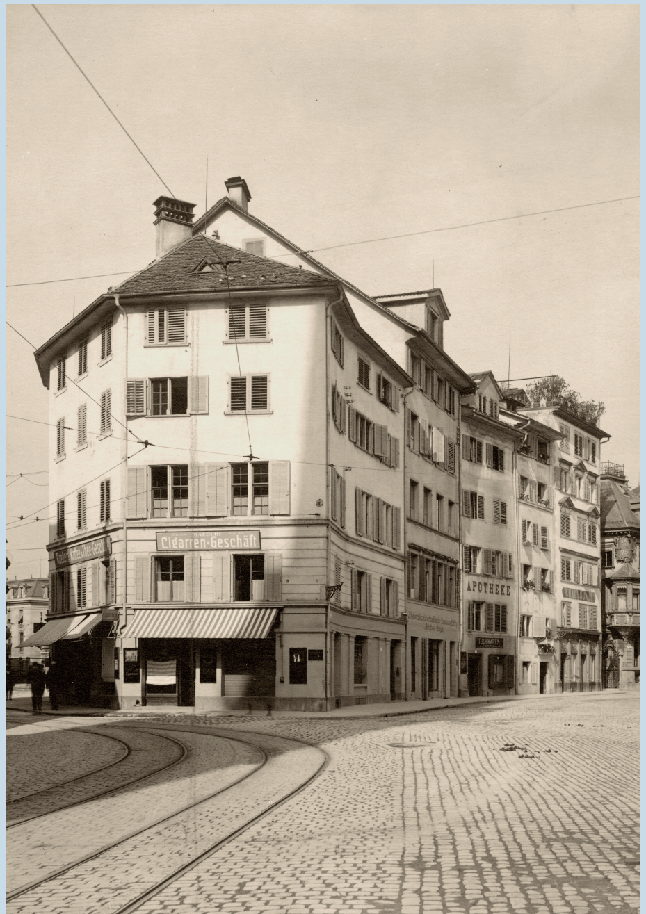
^ Das Haus «Zum Samaritan» musste 1937/38 der Neugestaltung der Südwestecke des Münsterhofes weichen. Auch die Tramgeleise auf dem Münsterhof sind längst Geschichte.
